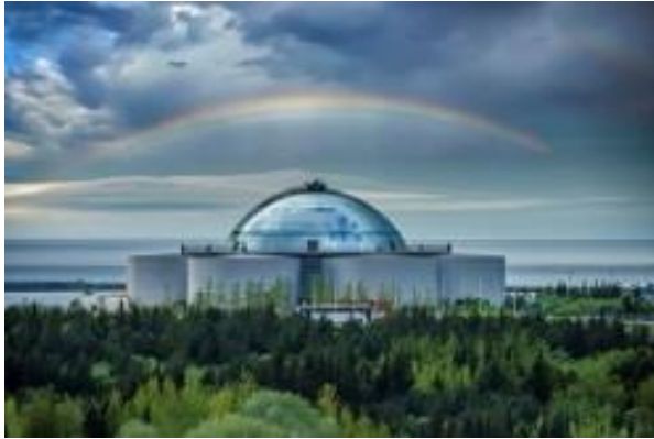
Im Herzen von Reykjavik erhebt sich weit sichtbar das Perlan mit seiner riesigen Glaskuppel und sechs Warmwasserspeichern. © Ragnar Th. Sigurdsson arctic-images.com
